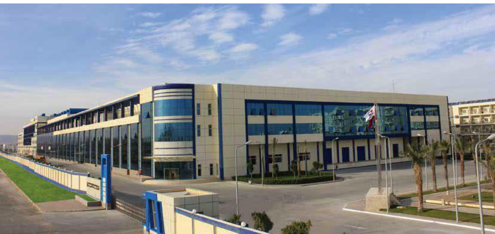
在埃及投资建设的年产20万吨玻纤生产基地
