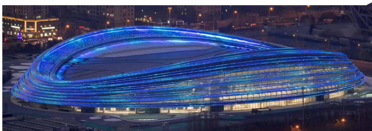
国家速滑馆（冰丝带）使用北新石膏板 8 万平方米、“龙牌”轻钢龙骨 70 吨
