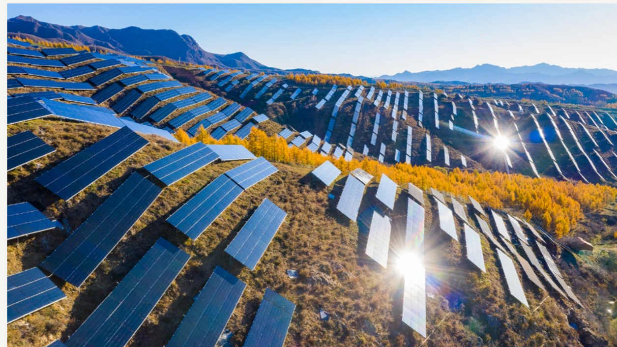
我国第一个大型碲化镉发电玻璃地面电站——张家口赤城县大型山地修复电站项目
