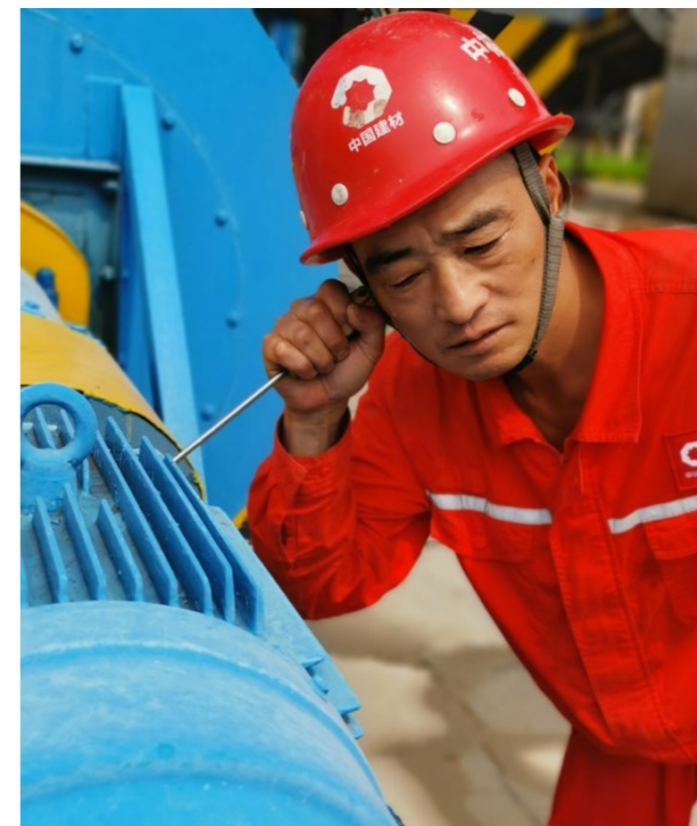
中材安徽水泥有限公司骨料电气工段长陈小保正在户外对骨料电气设备进行巡检维护，记录巡检和维护情况，及时排除隐患，确保电气设备安全稳定运行
