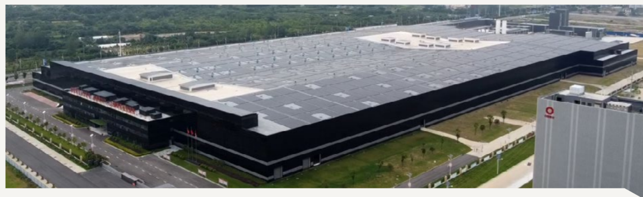
10MW 薄膜光伏建筑一体化（BIPV）应用示范项目——成都 8.5 代 TFT-LCD 超薄浮法玻璃基板生产线
